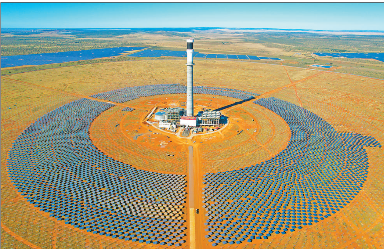
日前，由中国电建集团山东电建三公司承建的南非红石100兆瓦塔式熔盐光伏电站项目顺利实现并网发电，标志着项目建设进入关键阶段。图为南非红石100兆瓦塔式熔盐光伏电站项目全景。中国电建集团山东电建三公司供图
