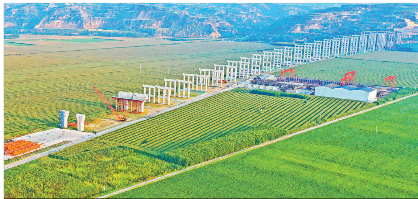
9月18日，河南省重点工程沁伊高速焦作市孟州黄河特大桥正在有序施工。沁伊高速（焦作市沁阳—洛阳市伊川）建成后，对提升周边城市的互联互通，促进区域协调发展具有重要意义。
