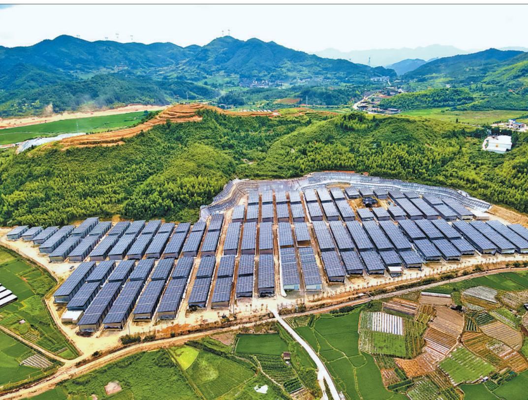
近年来，福建省宁德市古田县供电部门加大“光伏+菇棚”建设力度，推动光能和土地集约化、立体化综合利用。截至目前，当地已建成光伏菇棚基地9个，总装机容量27.1兆瓦，年上网发电量预计2396万千瓦时。图为古田县杉洋镇杉洋村“光伏+菇棚”食用菌基地。
