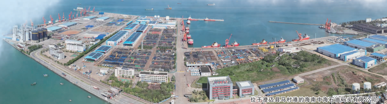
位于澄迈县马村港的海南中海石油码头有限公司
