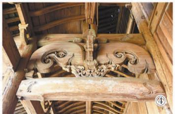
是最华丽的明代建筑遗存之一，是明代中后期徽州地区木构建筑的杰作。除了厅堂内梁架运用了月梁形制之外，其寝殿的11个开间正立面上的额枋也采用了月梁的造型，重檐配上月梁形的额枋，使得建筑越发庄严而华丽。
