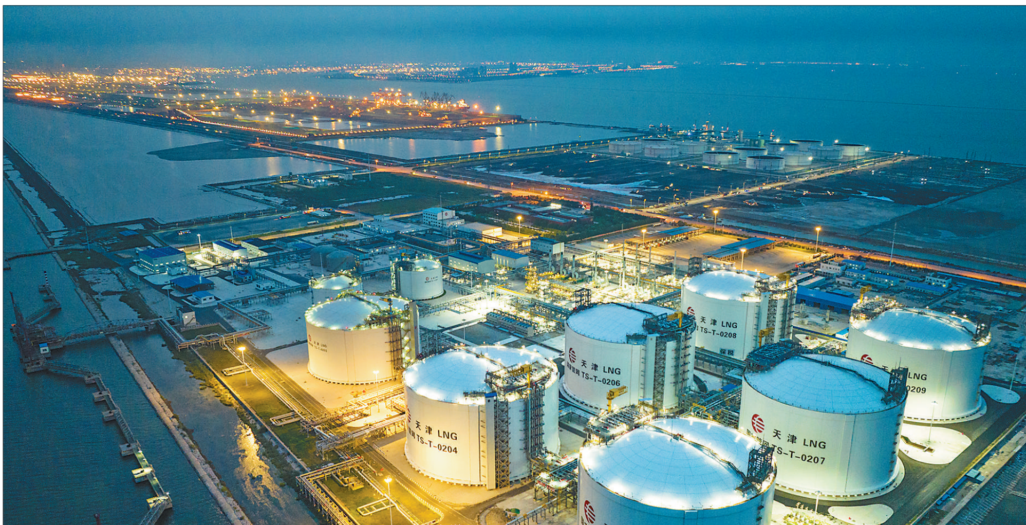
9月9日,国家天然气基础设施互联互通重点工程——国家管网集团天津LNG(液化天然气)接收站二期项目正式投产。投产后天津LNG接收站正式迈入千万吨级LNG接收站行列,将增强华北及周边区域天然气供应和应急调峰能力。图为夜色中的LNG接收站。杜鹏辉摄(影像中国)
