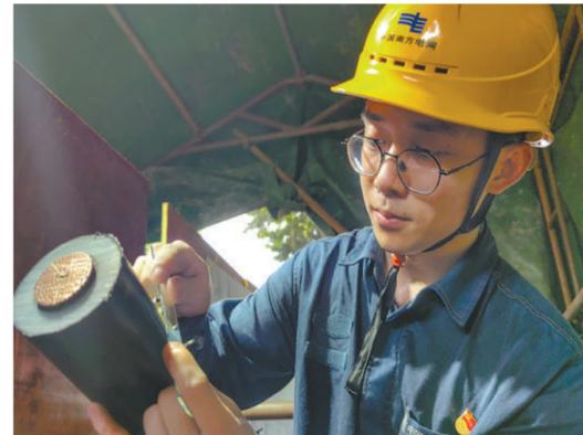
图为李濛在110千伏高压电缆线路施工现场制作电缆半导电接口。
