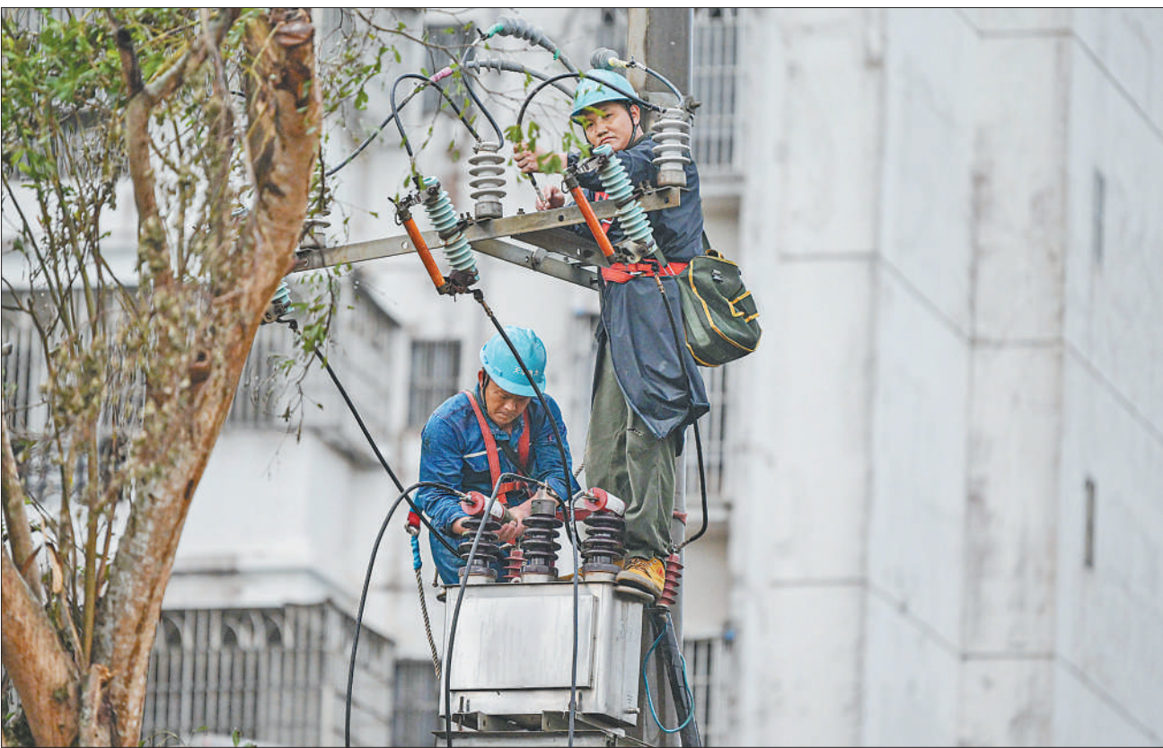
9月9日，在海南省澄迈县，驰援海南的电力工作人员在抢修电力线路。近日，受超强台风“摩羯”影响，澄迈县生产、生活用电受到影响。连日来，海南电网公司澄迈供电局、海南送变电工程有限公司及驰援海南的电力抢险队等在澄迈县各地抢修电力线路，力争早日恢复正常供电。
