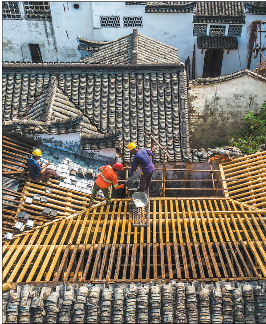
浙江省兰溪市诸葛村,施工人员正在修缮一处古建筑屋顶。
