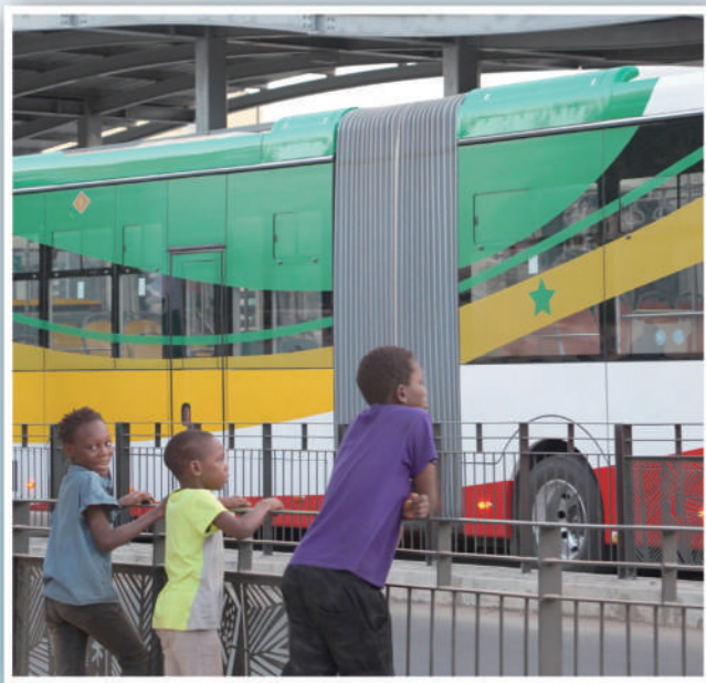
中企承建的塞内加尔达喀尔快速公交系统项目。
