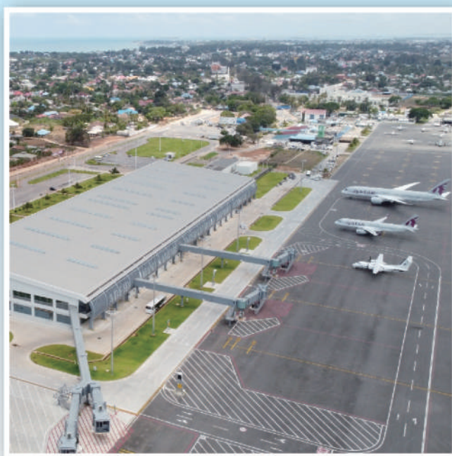
中企承建的坦桑尼亚桑给巴尔国际机场3号航站楼。
