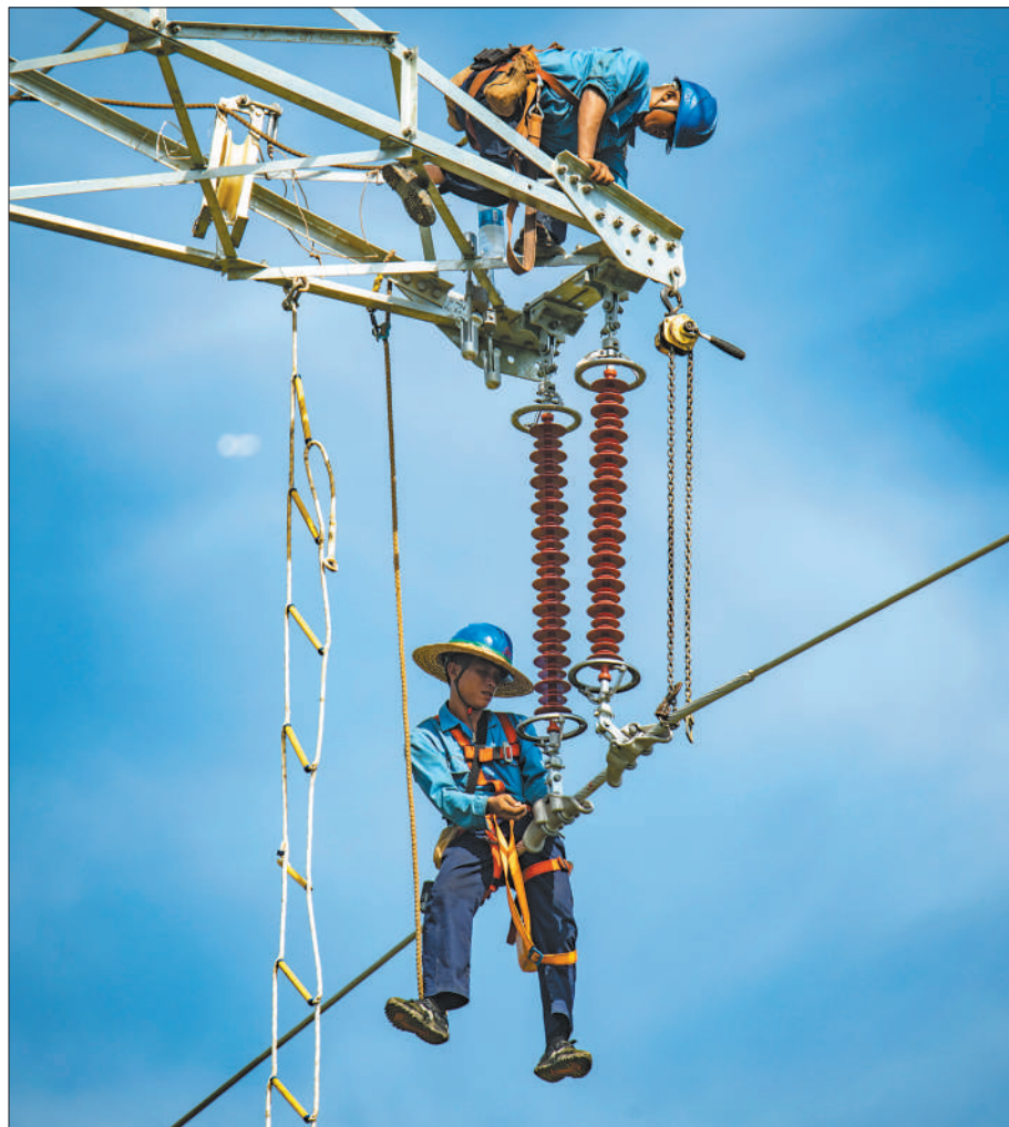
海南省琼海市嘉积镇，电力工人在架设输电线路。
