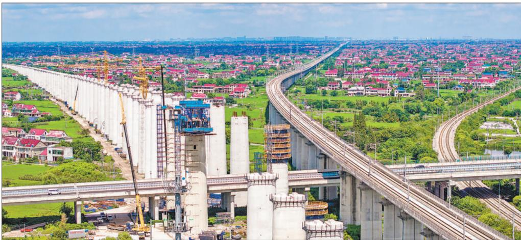
8月29日,由中铁建十四局承建的沪渝蓉高铁通泰扬特大桥跨锡通高速公路连续梁建设现场,施工正在进行。(阮忠摄(影像中国))
