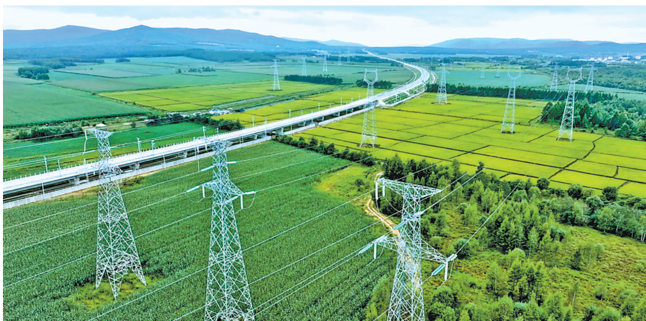
8月30日,我国在建最长高铁——黑龙江哈尔滨至伊春高铁铁力至伊春段外部供电工程建成投运。哈伊高铁是我国在建纬度最高、首条穿越多年冻土区的高速铁路,建成通车后将为地方经济社会高质量发展注入新活力。图为哈伊高铁铁力段外部供电工程线路。本报记者 方圆文 孔祥钰摄(人民视觉)
