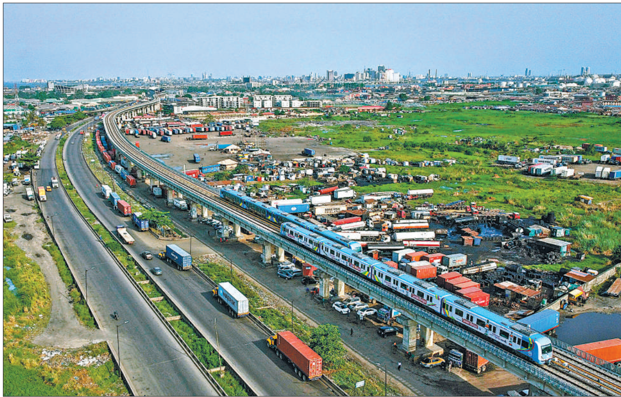
由中企承建的尼日利亚拉各斯轻轨蓝线采用全电力列车,为通勤者提供了绿色、环保和节能的出行方式,有效减少了有害气体排放,助推非洲绿色可持续发展。
