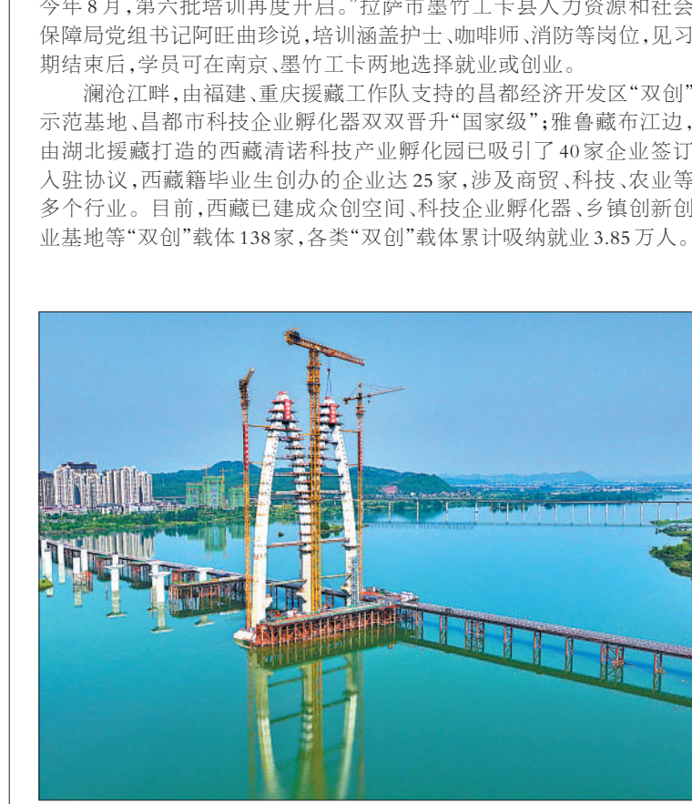
近日，四川省遂宁市洛江六桥(袁家坝渡改桥)主塔顺利封顶。该桥由蜀道集团四川路桥桥梁公司承建，是遂宁境内首座斜拉桥，建成后连接洛江两岸城市区域中心，方便群众出行。王明峰 魏睿凯摄影报道
