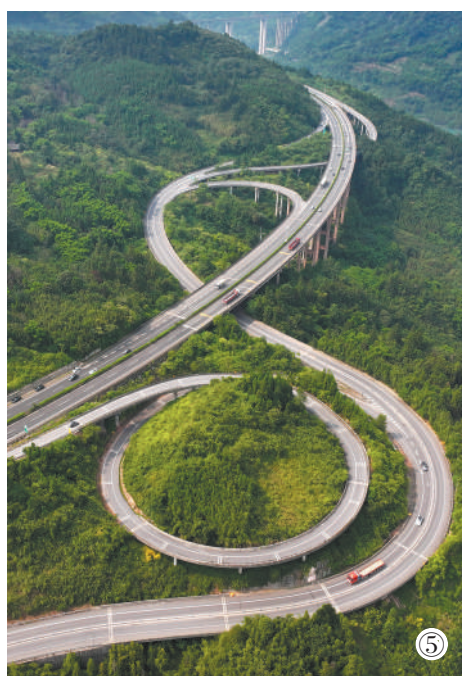
图⑤:8月22日拍摄的雅西高速龙苍沟互通。该高速连接四川雅安和西昌,建设难度极大。本报记者 雷声摄
