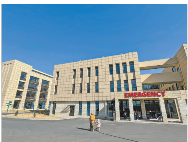
中国援建莱索托马塞卢地区医院和眼科诊所项目于今年6月移交莱方，为马塞卢及周边居民提供有力的医疗保障。图为马塞卢地区医院急诊大楼。
