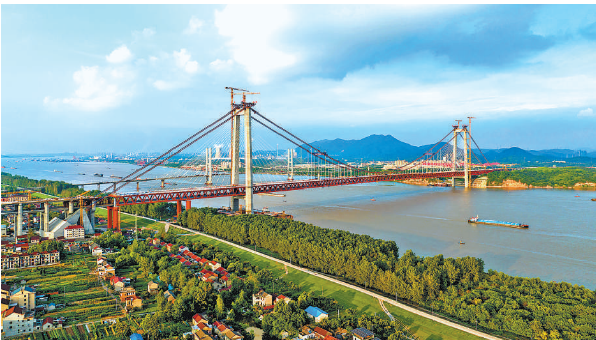
世界首座双层斜拉—悬索协作体系大桥顺利合龙
