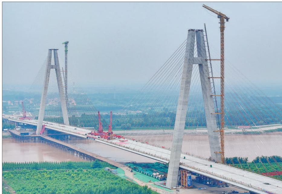
8月25日,山东东营东津黄河大桥顺利合龙。东津黄河大桥全长1607米,跨黄河主桥跨径达420米,是德州路西延建设项目的关键控制性工程。大桥建成投用后,将进一步缓解跨黄河交通压力。 周广宇摄(影像中国)
