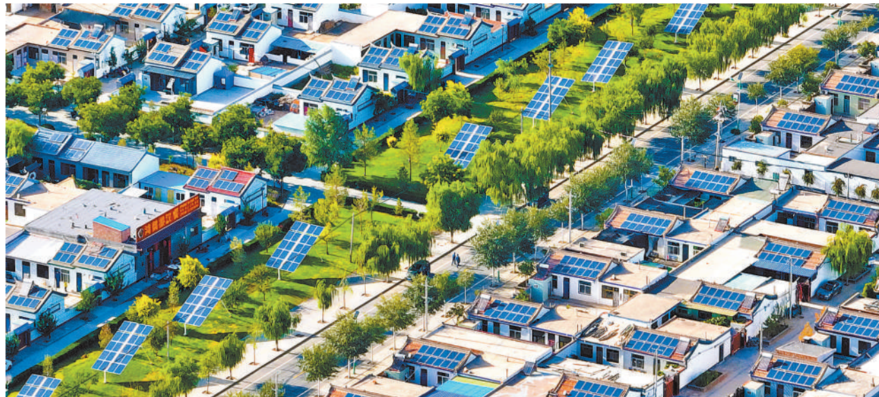
宁夏银川市永宁县闽宁镇加快推进“绿电小镇”建设,着力构建以清洁能源为主的绿色电网工程,风光互补资源互补,实现24小时绿电供应的发展目标。图为8月23日拍摄的闽宁镇原隆村的屋顶分布式光伏与光伏产业园区。 袁宏彦摄(影像中国)
