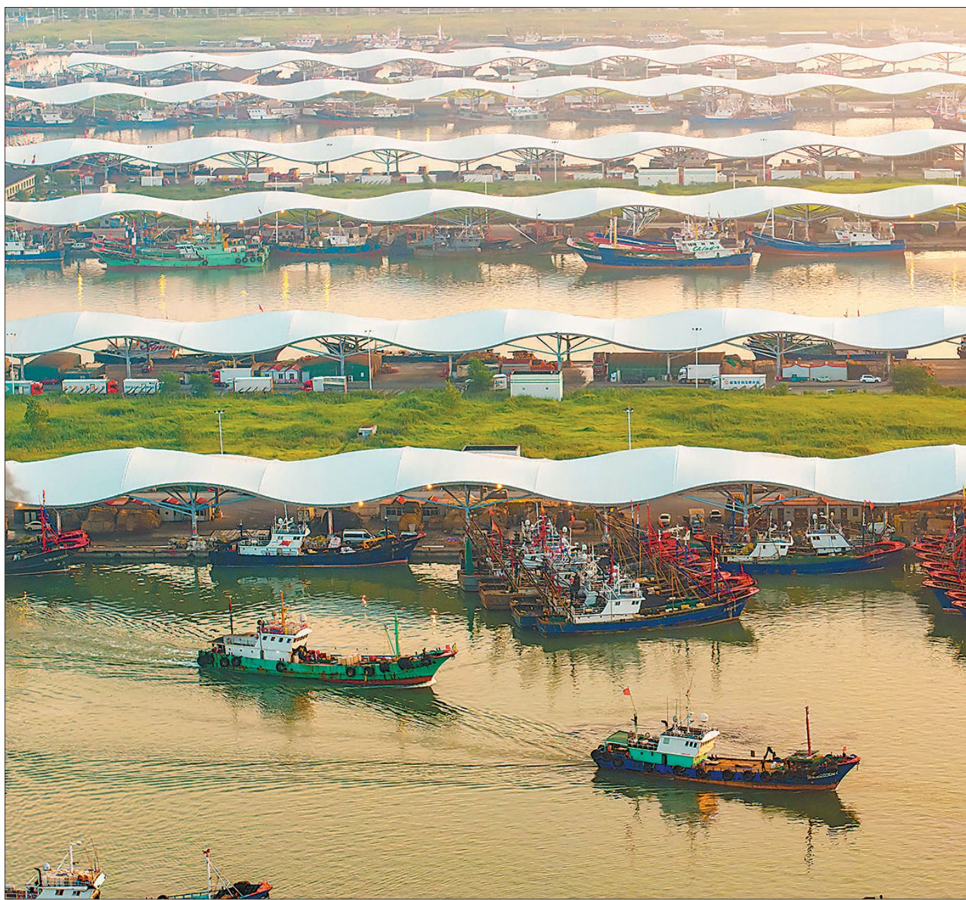
8月21日清晨,位于江苏省启东市的吕四国家中心渔港,渔船在进行停靠、补给、卸鱼、海产品转运等作业,一派忙碌景象。陆启辉摄(人民视觉)
