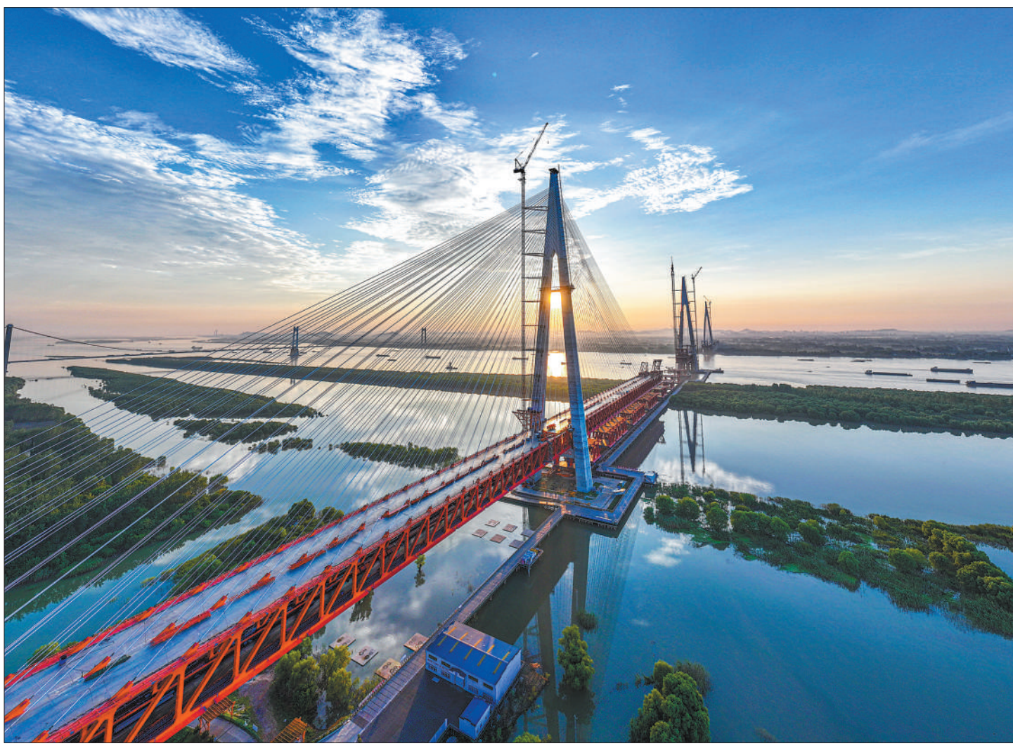
图为安徽省马鞍山市郑蒲港新区建设中的马鞍山长江公铁大桥。这座公铁两用大桥是巢马城际铁路控制性工程，为世界上首座双主跨超千米的三塔斜拉桥、世界最大跨度三塔斜拉桥，同时也是世界上最长联钢桁梁斜拉桥。
