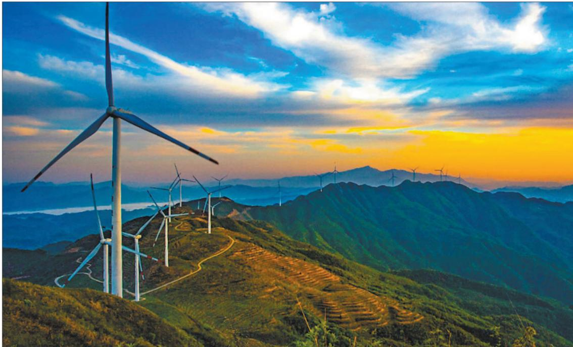
左图:贵州省铜仁市石阡县大顶山风力发电场,每年可输送1亿千瓦时的清洁电力,节约4.4万吨标煤,减少11万吨二氧化碳排放和3300吨左右二氧化硫排放。
