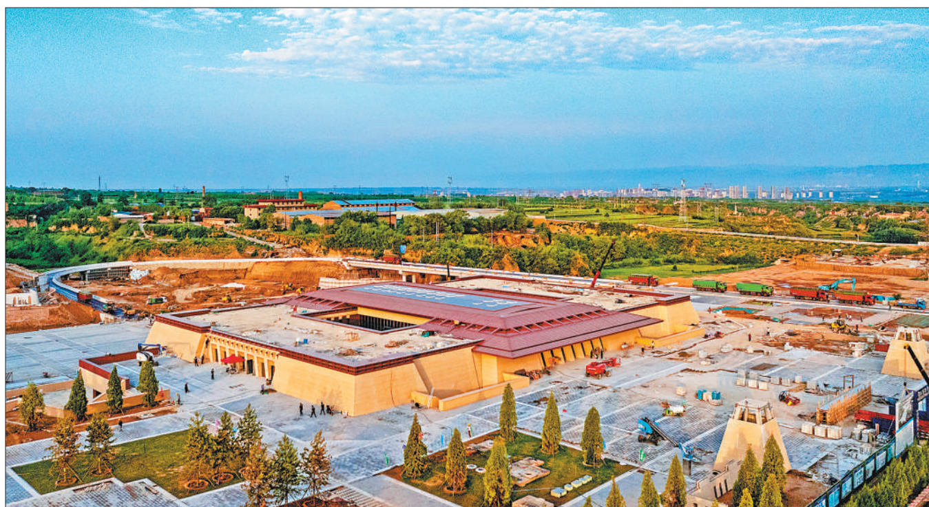
日前,山西省临汾市陶寺遗址博物馆建设正在加快推进。据了解,陶寺遗址博物馆占地面积74.4亩,建筑面积1万平方米,地下一层,地上二层。建成后利用数字复原现代化展陈与实物展陈等多种形式展示陶寺文化。图为陶寺遗址博物馆项目建设现场。李现俊摄(影像中国)
