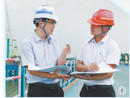
图①:曾敏(左)在天子山大桥项目工地讨论施工有关技术问题。 图②:天子山大桥基础施工平台。 欧巍摄 周阔阁摄 版式设计:沈亦伶
