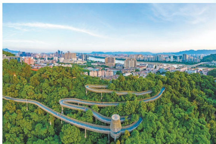
福建福州市在建设“福道”时,采取钢结构高架、镂空桥面栈道、节点大跨度桥梁等创新设计,最大限度保护森林原生态。 林双伟摄(人民视觉)
