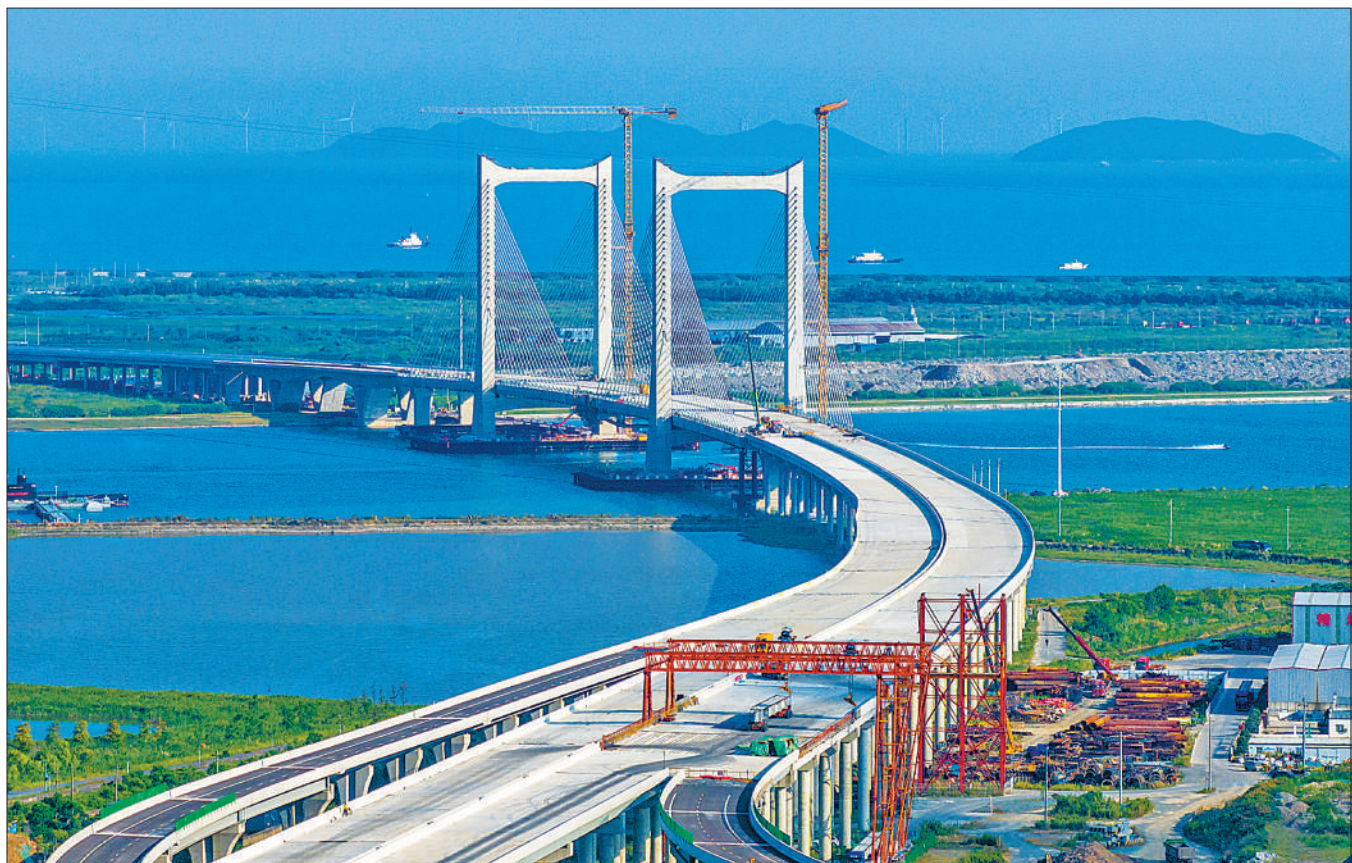
8月13日,浙江宁波舟山港六横公路大桥一期工程控制性节点梅山水道桥中跨顺利合龙。宁波舟山港六横公路大桥建成后,可实现六横岛、佛渡岛、梅山岛三岛产业联动,对推进长三角一体化发展具有重要意义。胡学军摄(影像中国)
