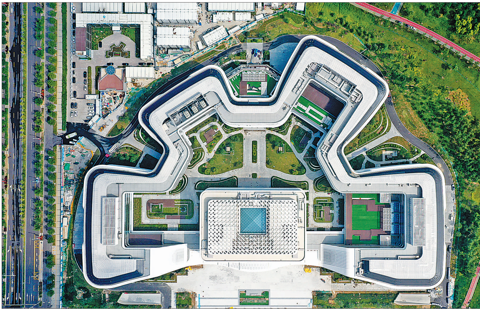
8月8日，位于雄安新区启动区内的中国卫星网络集团有限公司总部大楼正在进行内部装修，有望在今年投用。包括中国星网在内的首批4家疏解央企的雄安总部项目建设在持续推进。
