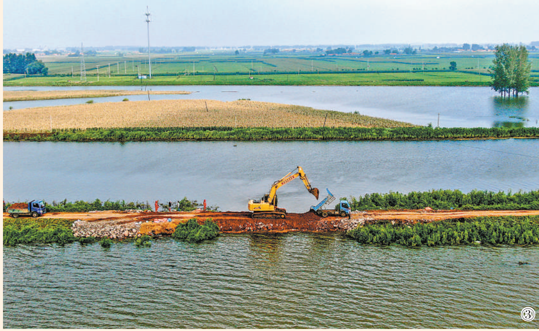
图①:8月6日,黑龙江省宁安市宁安镇兴盛村二组,民兵救援队驾驶冲锋舟为村民返村和运送生活物资提供帮助。 张春祥摄(人民视觉) 图②:8月6日,中国安能在湖南省郴州市资兴市抢修田坪村进村受损道路。 杨迅 全浩宇摄影报道 图③:8月7日4时27分,辽宁省铁岭县境内的王河右岸范家窝棚村段溃口封堵完成。图为8月7日,抢险人员在现场进行加固工作。 新华社记者 潘昱龙摄
