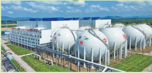
▲泰安市肥城300兆瓦先进压缩空气储能示范项目全景。该项目年发电量达6亿千瓦时，每年可节约标准煤约18.9万吨，减少二氧化碳排放约49万吨。
