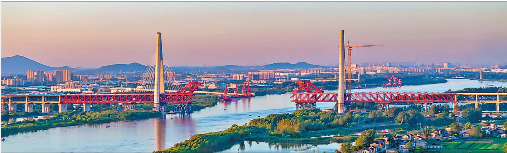
安徽省马鞍山当涂县境内的巢马(巢湖至马鞍山)城际铁路马鞍山长江公铁大桥副汉航道桥进入镀锌钢绞线斜拉索安装阶段。项目建成运营后,将在皖江两岸建起一条新通道,对推动长三角一体化发展和长江经济带建设等具有重要意义。图为7月29日拍摄的巢马城际铁路马鞍山长江公铁大桥副汉航道桥施工现场。
