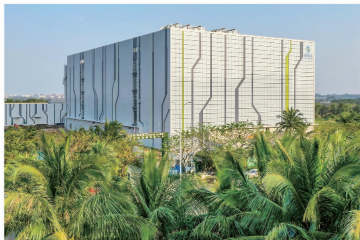
海口江东新区的中国移动(海南海口)自贸港互联网数据中心(IDC)项目
