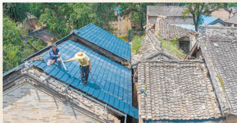
▲施工人员为伯方村的古建筑屋顶加盖防水瓦片。
