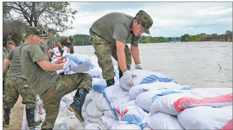
7月29日,在松花江支流牡丹江的黑龙省宁安市区段,当地干部群众正在堆砌防汛子堤。张春祥摄(人民视觉)
