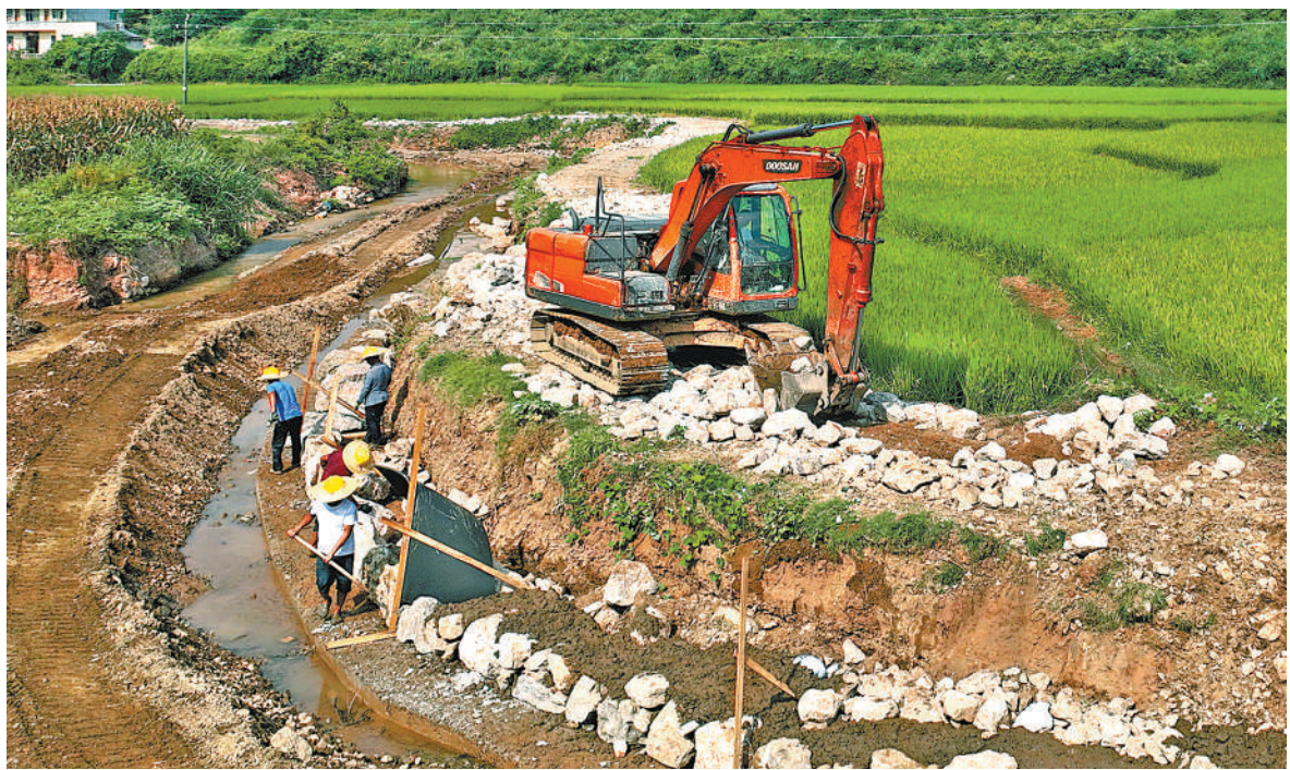
7月26日，湖南省洪江市岩垅乡坪垅村，施工人员加紧修复被洪水冲毁的溪边农田保坎。杨锡建摄（人民视觉）
