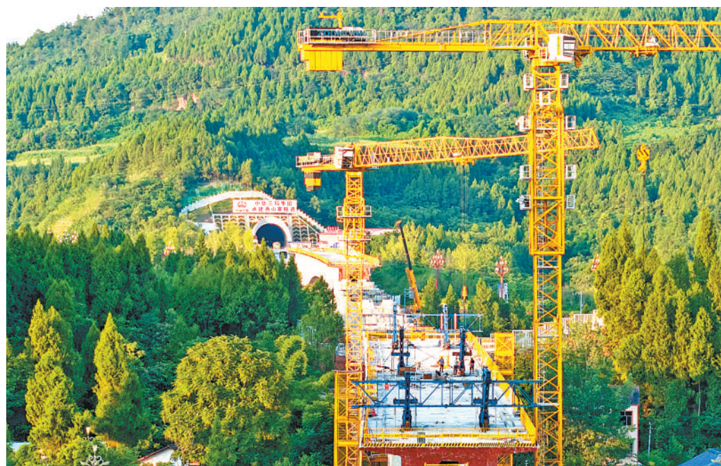
成达万(成都至达州至万州)高铁是我国“八纵八横”高铁网沿江通道的重要组成部分,项目建成后,将助力成渝地区双城经济圈建设,便利沿线群众出行,推动经济社会高质量发展。图为位于四川省南充市蓬安县的成达万高铁铁山隧道进口施工现场。(彭圣洲摄/影像中国)
