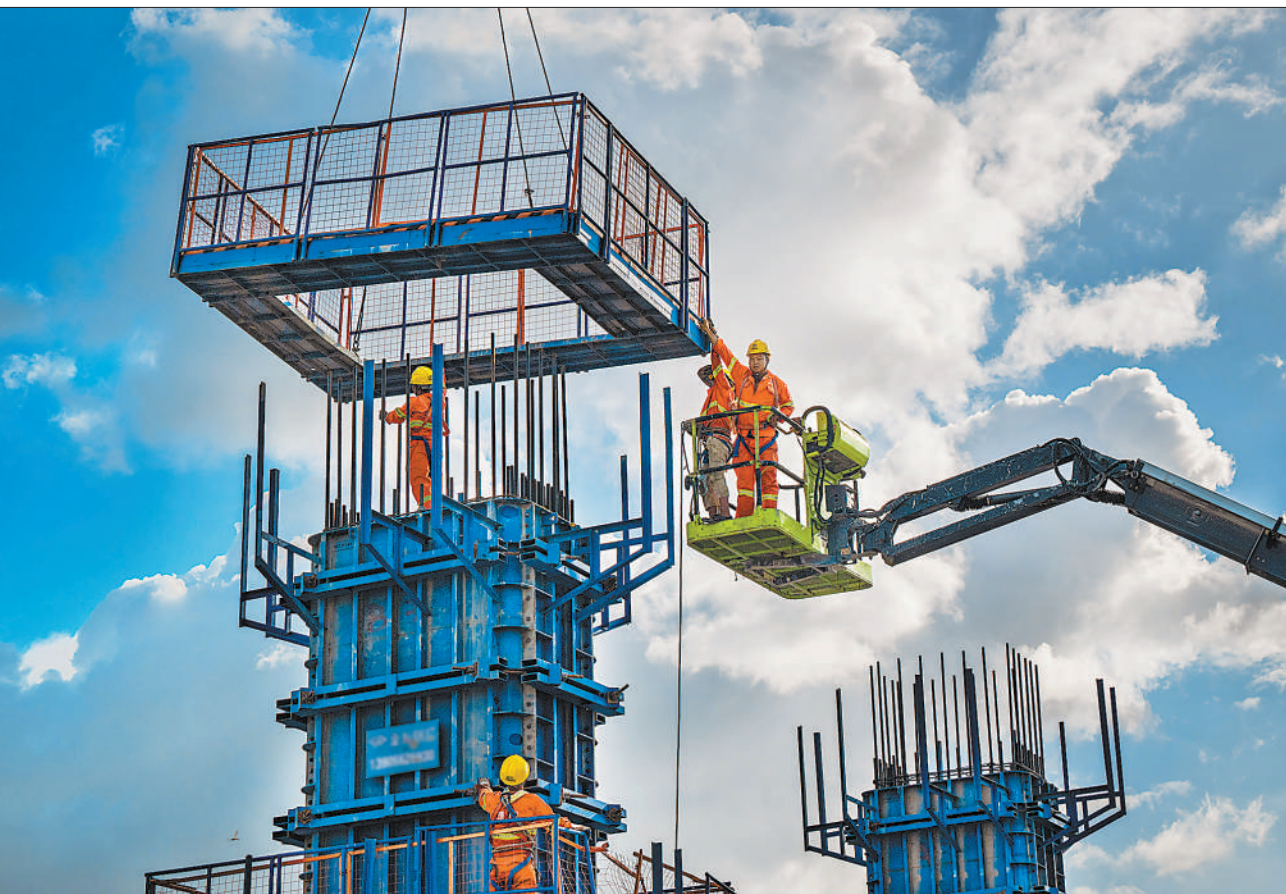
7月24日，浙江省宁波市九龙大道快速路工程项目工地，工人在吊装钢模。工程建成后，将进一步完善市域快速路网。胡学军摄(人民视觉)
