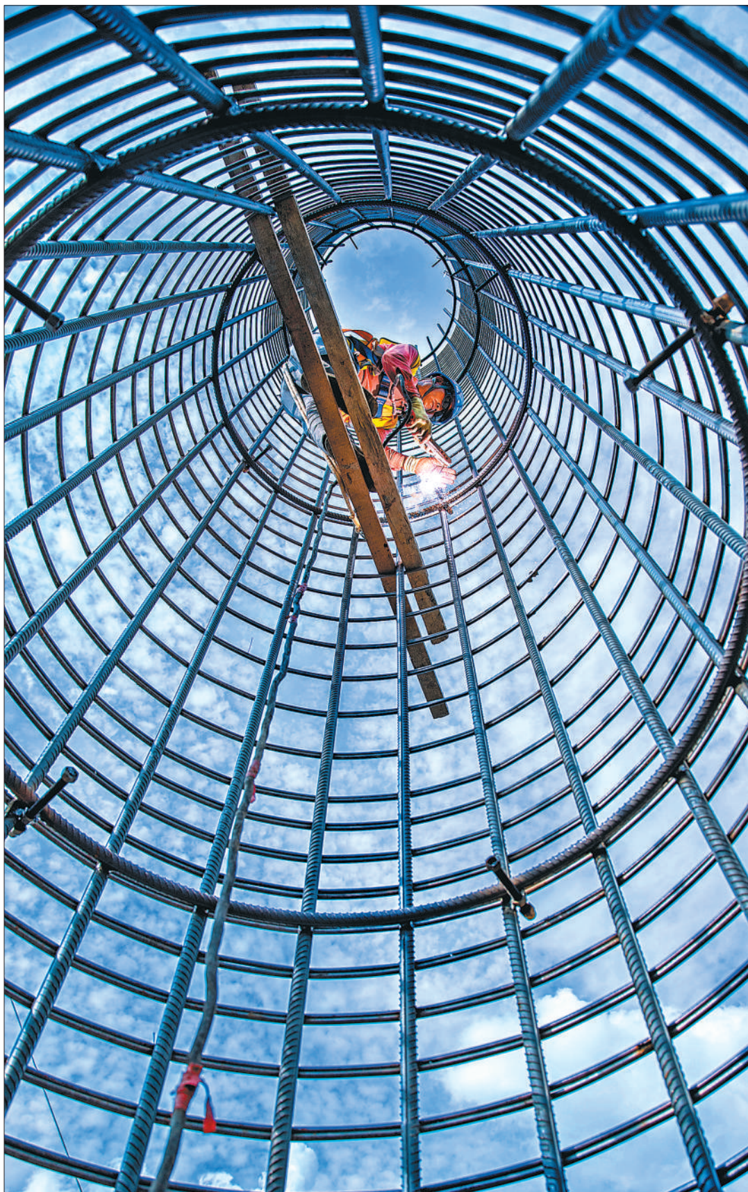
东兴高速连接江苏省东台市和兴化市,全长37.73公里,为江苏省规划“十五射六纵十横”高速公路网中的一条重要联络线。图为7月23日,东兴高速东南互通主线桥立柱钢筋笼内,工人正在施工。
