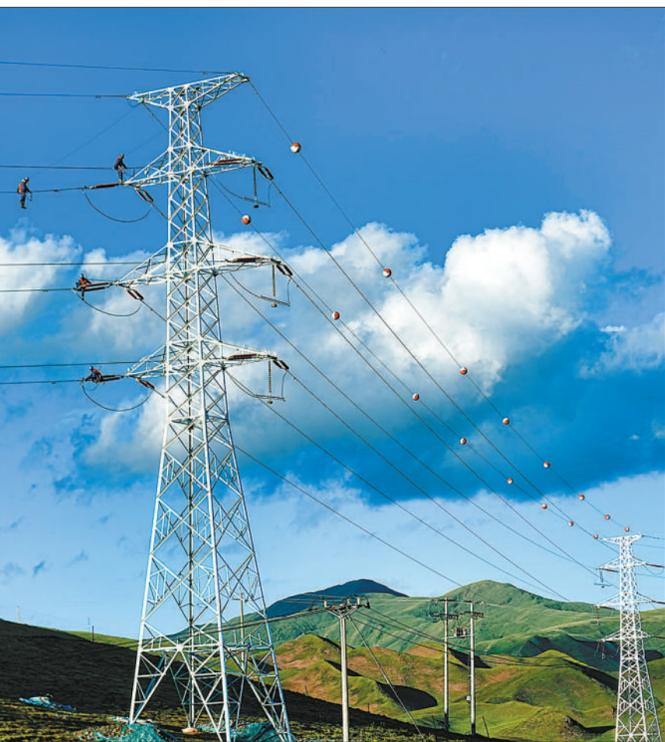
地处青藏高原腹地的三江源地区,是长江、黄河、澜沧江的发源地,气候寒冷,采暖期长。近年来,青海省持续推动三江源地区清洁取暖全覆盖,减少煤炭等燃料使用,让三江源的天更蓝、水更清、人民更幸福。图为国网青海果洛供电公司工作人员正在玛沁县110千伏智格输变电工程施工现场进行引流线搭接工作,该工程完成后将满足当地清洁供暖用电负荷增长的需求,为三江源地区稳定用电提供保障。
