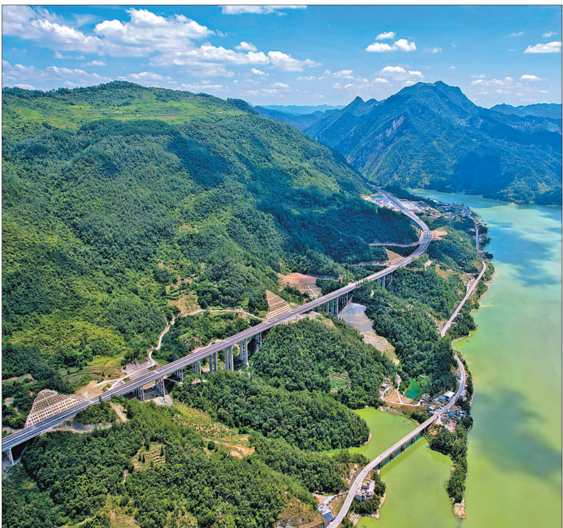
7月23日，在重庆市酉阳土家族苗族自治县龚滩镇，渝湘复线高速公路鱼梁溪特大桥项目进入扫尾施工阶段。渝湘复线高速公路是西部陆海新通道东线的重要组成部分。冉川摄（影像中国）
