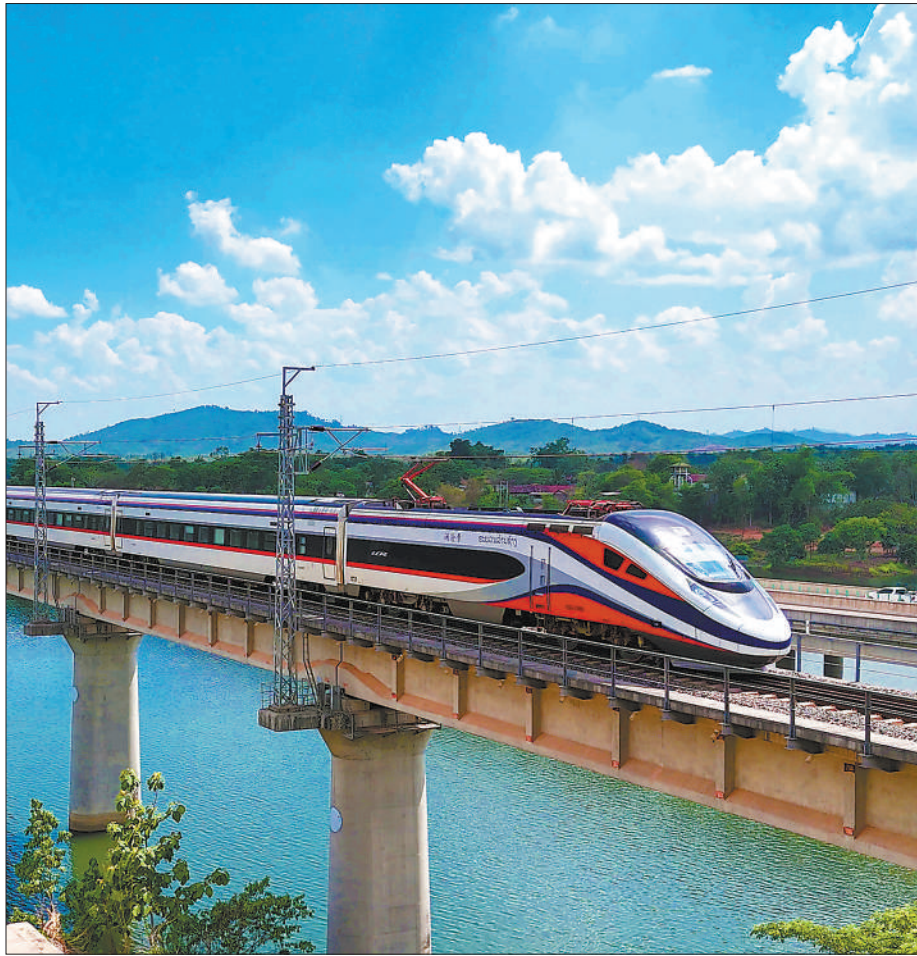
中老铁路国际旅客列车经过老挝琅勃拉邦省内的湄公河特大桥。
