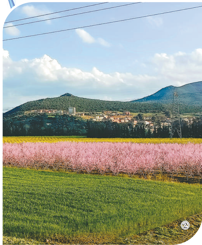
图①:汽车行驶在阿尔及利亚东西高速公路上。何勇摄 图②:阿尔及利亚东西高速公路东标段84公里项目路侧粮食和经济作物生机勃勃。吴华珍摄 图③:阿尔及利亚斯基克达油气港正在建设的泊位。本报记者任皓宇摄 图④:阿尔及利亚康斯坦丁粮仓正在进行粮食装车。本报记者郝瑞敏摄 图⑤:阿尔及利亚东西高速公路贝贾亚连接线施工现场,中阿两国建筑工人正在绑扎桥桩基钢筋笼。本报记者薛丹摄 底图:阿尔及利亚东西高速公路一景。王黎旭摄
