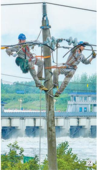
图②：7月20日，江苏宿迁供电部门阳光送变电抢修队抢修人员紧急搭接因降雨断开的线路。
