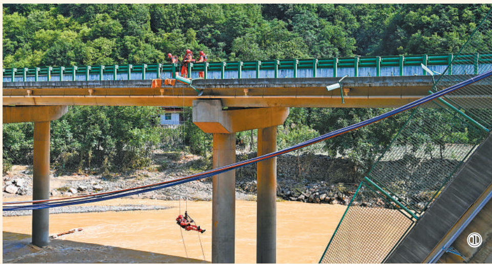
图①:7月21日,救援人员在陕西商洛市柞水县境内高速公路桥梁垮塌现场进行搜救。
