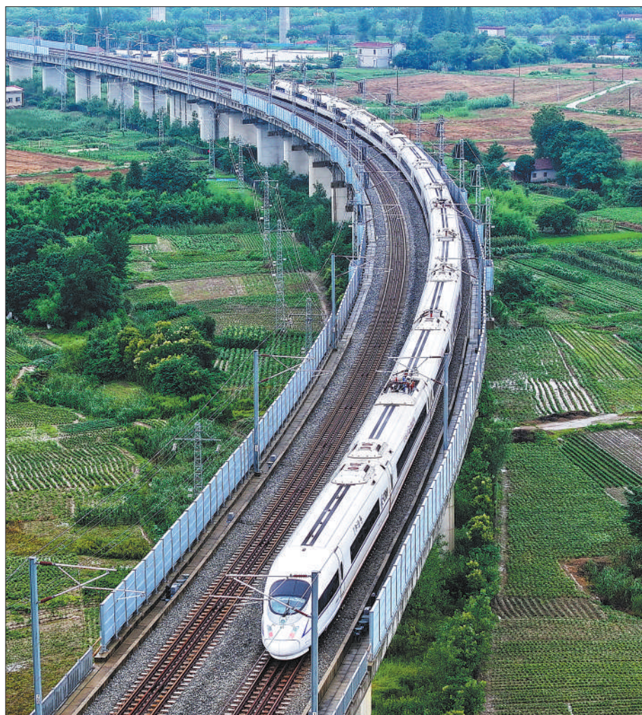
中国铁路上海局集团有限公司南通动车所助力长三角铁路暑运,动车组检修数量、过夜存放车组数等均有所增长。图为动车组驶出南通动车所。 许丛军摄(人民视觉)
