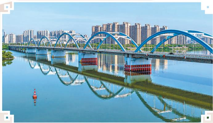
▲海口琼州大桥,2003年建成,位于海南海口市,为五孔下承式钢管混凝土系杆拱桥。
