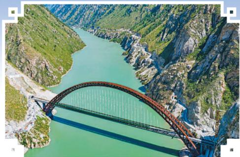
▲藏木雅鲁藏布江大桥,2021年建成,位于西藏山南市,为拉林铁路标志性工程,是世界海拔最高、跨径最大的铁路钢管混凝土拱桥。
