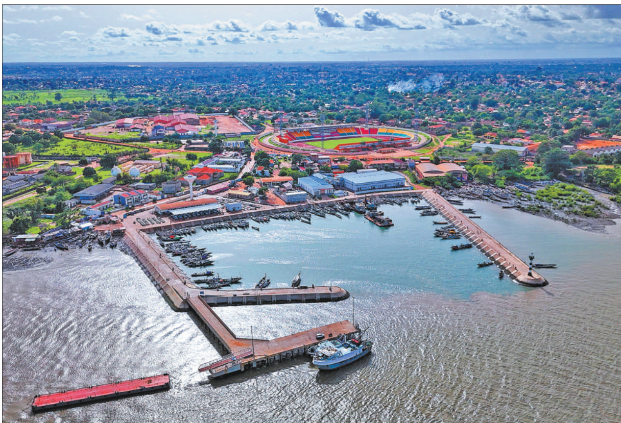
渔业是几内亚比绍的支柱产业之一。近年来，中国和几内亚比绍携手推进务实合作，发展蓝色经济，为当地人民带来实实在在的好处。2023年，中国援建的板丁渔业码头项目移交；中企投建的水产品加工存储综合设施正式运营，成为该国最大的现代化渔业加工厂。图为近日拍摄的板丁渔业码头和水产品加工存储综合设施。新华社记者 韩旭摄
