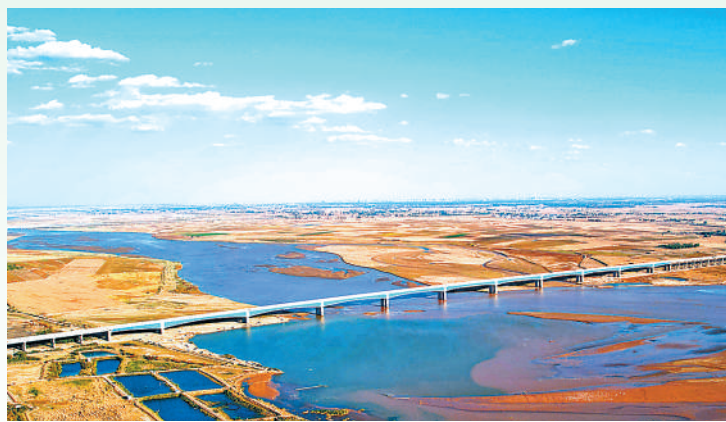
▲昭君黄河特大桥连通内蒙古自治区包头市和鄂尔多斯市，是国内联长最长波形钢腹板梁桥，于2022年9月建成，对促进呼包鄂榆城市群协同发展具有重要意义。张 彬 张书铭摄影报道
