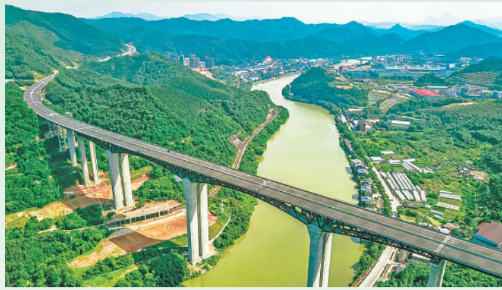
▲位于福建省三明市的沙溪大桥，2022年正式投用，采用主跨176米的钢桁组合连续刚构，为世界上同类型桥梁最大跨径，丰富了山区大跨径梁桥桥型方案。张 滔摄(人民视觉)
