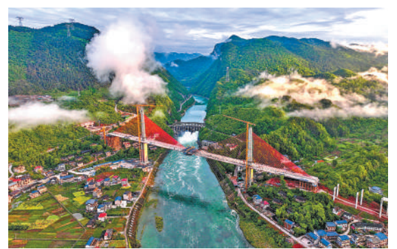
▲安家庄特大桥位于北京市门头沟区安家庄村，全长2.2公里，为全球首例墩顶双转体曲线钢桁梁斜拉桥，解决了钢管混凝土桥墩两端传力构造等技术难题。本报记者 张武军摄
