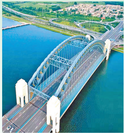
▲位于山西省太原市的晋阳桥，主跨204米，为下承式钢桁架拱桥，于2019年6月建成通车，横跨汾河。付明丽 贺子毅摄影报道
