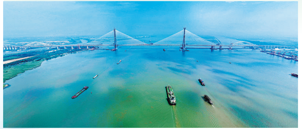
▲6月9日，连接江苏省常州市和泰州市的世界最大跨度斜拉桥常泰长江大桥顺利合龙。该桥全长超10公里，主跨1208米，是长江上首座集高速公路、城际铁路、普通公路于一体的过江通道。陈 曦摄(人民视觉)
