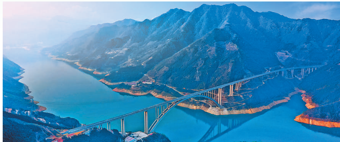
▲2月1日，世界最大跨径拱桥天峨龙滩特大桥建成通车。该桥位于广西壮族自治区天峨县龙滩大坝上游，横跨红水河，全长约2488米，主跨超600米。张云河 朱 灵摄影报道
