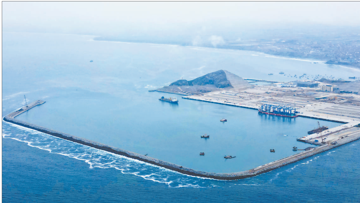
近年来，中国企业积极参与拉美基建投资建设，为拉美国家和人民带来了实惠。由中企控股和投资开发的钱凯港项目位于秘鲁首都利马以北的钱凯湾内，建成后将成为拉美地区新的枢纽港和太平洋门户港，可大幅缩短秘鲁到亚洲的直航时间。图为钱凯港建设现场。 丘艳摄
