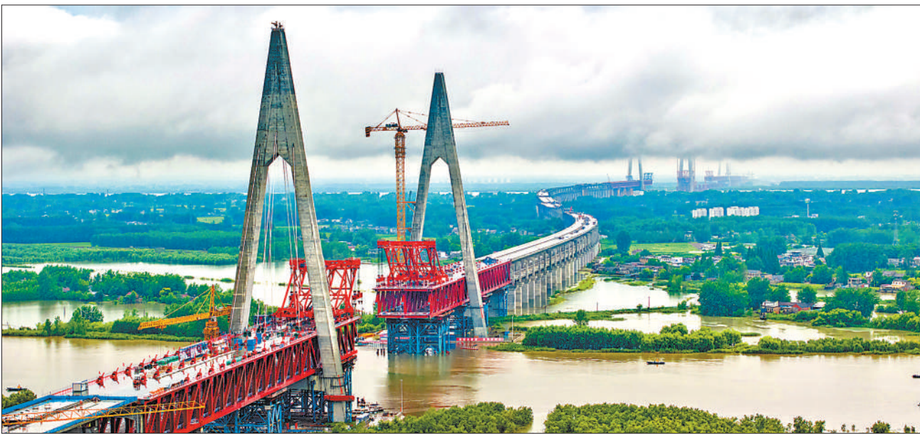
7月12日，巢马城际铁路马鞍山长江公铁大桥斜拉索施工阶段。该桥建成后，将成为安徽通往长三角城市高铁新通道的重要组成部分，对进一步完善区域高速铁路网布局具有重要意义。刘玉才摄（影像中国）
